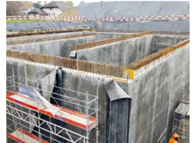
Après la pose d'une étanchéité, l'ouvrage sera recouvert de terre et engazonné pour être ainsi complètement enterré. Les travaux seront finalisés dans le courant de 2020.
